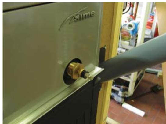
Fig. 28 Termostato di sicurezza
