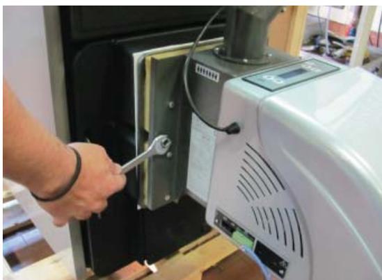
Fig. 25 Montaggio bruciatore
